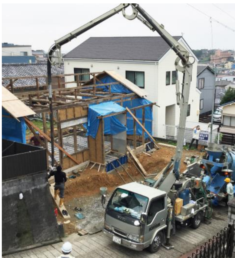
図-8 「がんばり坂の家」のスケルトンリフォーム(株式会社リージョン・スタディーズ HP より)
