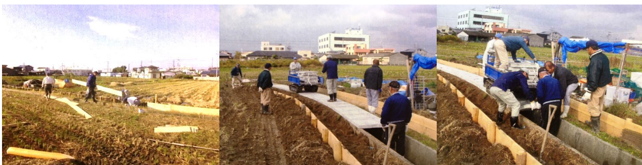
既存の水路脇に杭を打ち、柵板を施工して、水路に蓋板を設置する工程。この後、柵板と水路の間に土を詰め固めて竣工となる (写真) 太平寺地区農空間保全活性協議会提供
