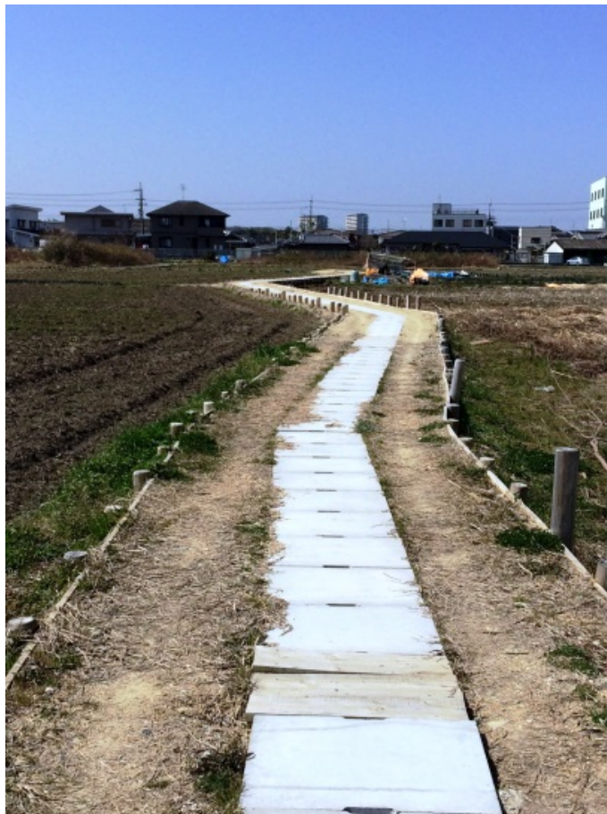
竣工した農道 (写真)筆者撮影
