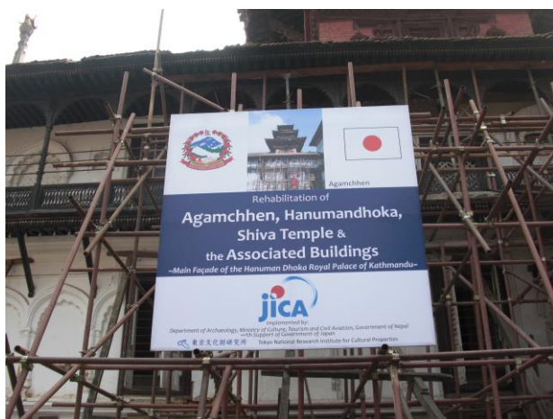
2015年ネパール地震で被害を受けたカトマンドウの文化遺産の日本支援による修復工事 (2018年3月14日 筆者撮影)
