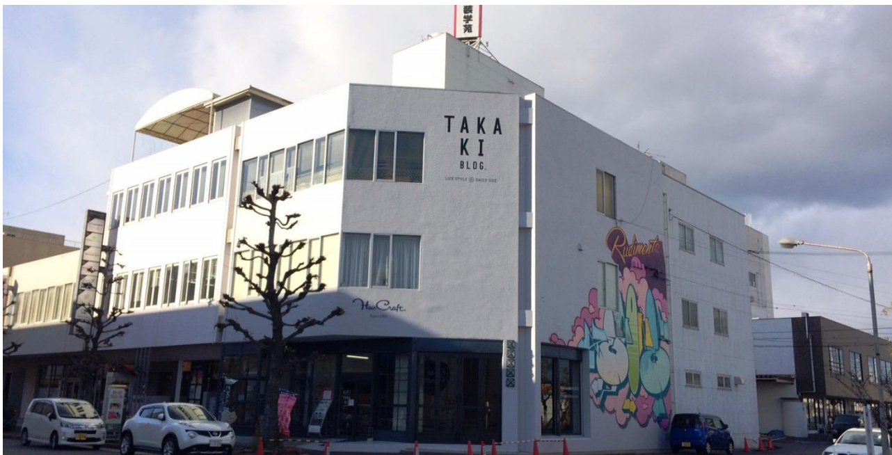
(写真)ZENONEによるグラフィティが描かれたビル(筆者撮影)
