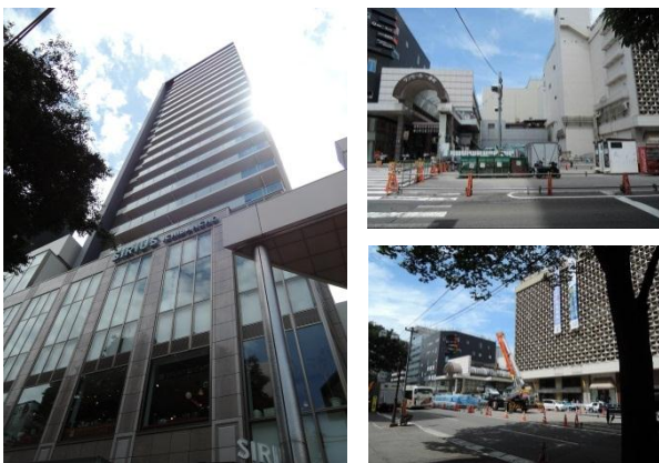
(写真3) ザ仙台タワー (写真4) 藤崎新店舗工事
