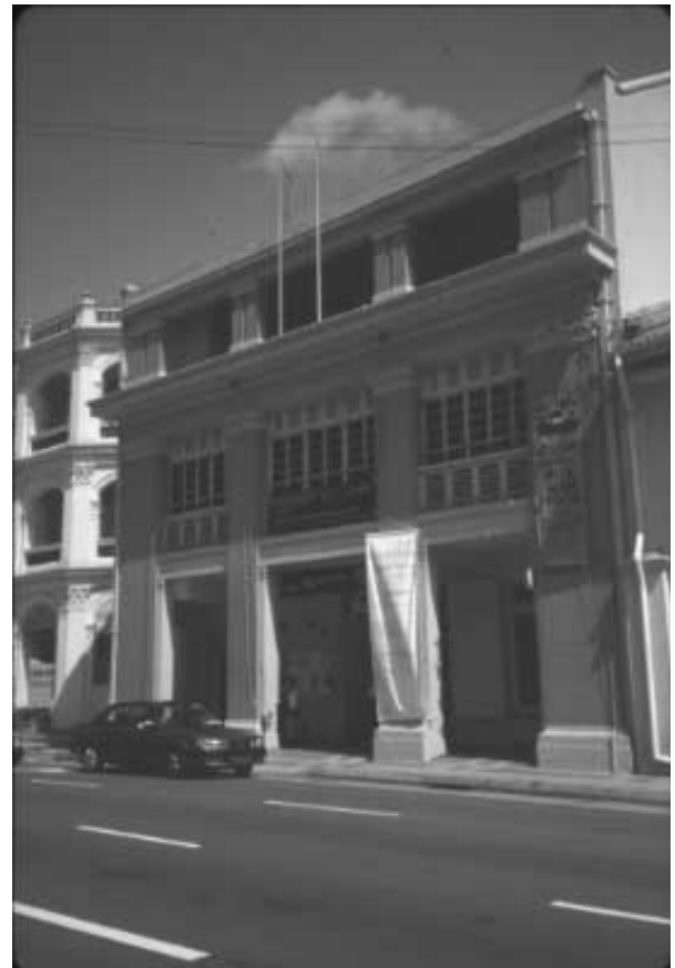
写真-1 Substationの外観
