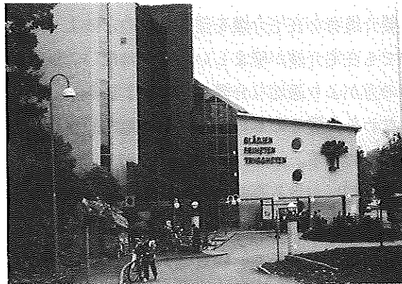
(写真6) スウェーデンの複合介護施設： 「TRYGGHETEN」(ストックホルム市)
