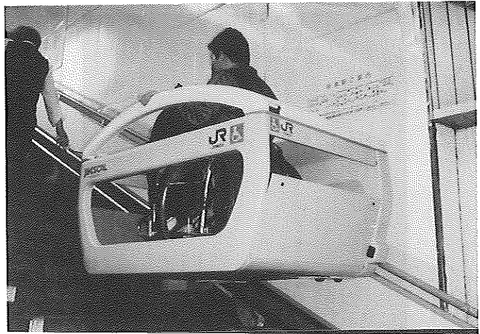
(写真7) JR王子駅の階段昇降装置
