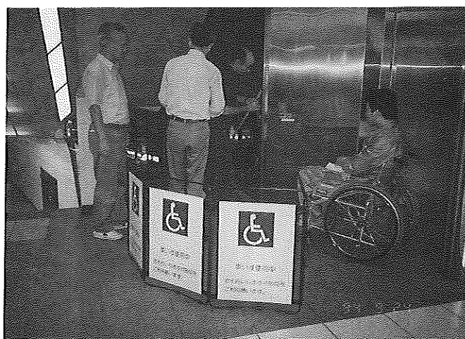
(写真4) 車いす乗用ステップ付エスカレーター
