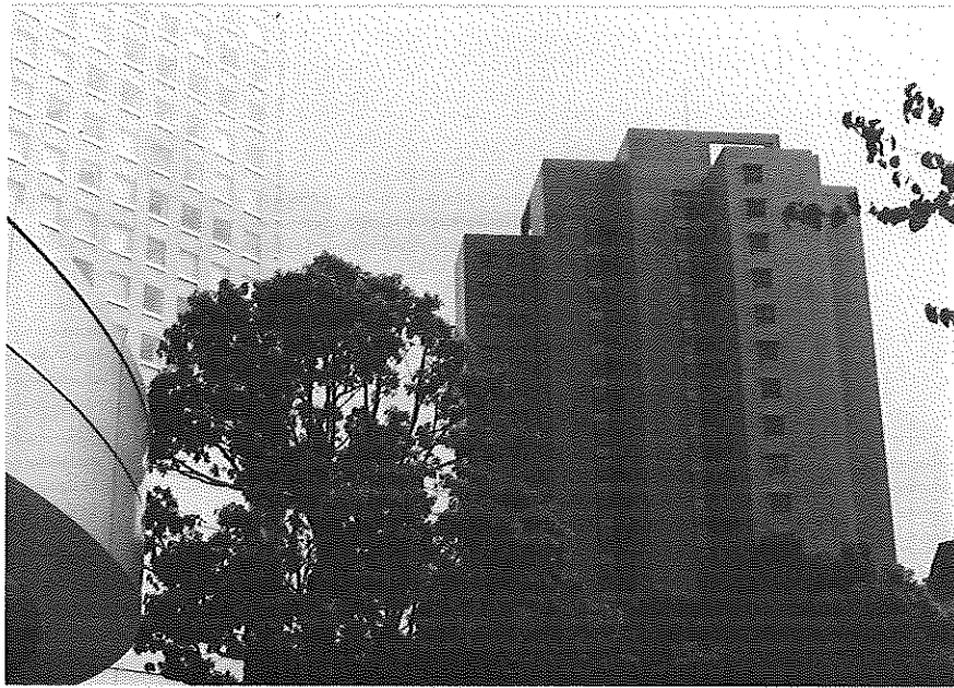
三井倉庫箱崎ビル……市住総を活用した大規模オフィスと付置義務住宅である。 (中央区) 超高層住宅は1つの都市居住形成としての特殊解では。
