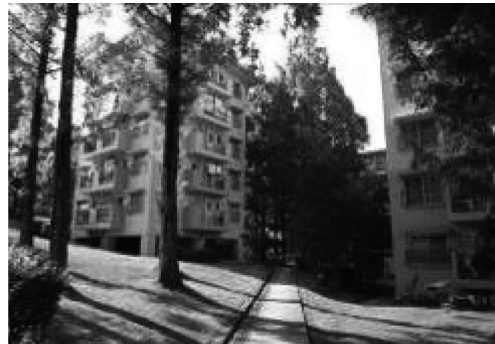
写真2 千里青山台団地（昭和40年代団地）
