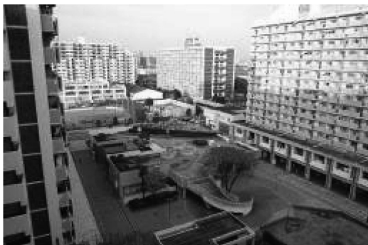
写真3 北砂5丁目団地（昭和50年代団地）
