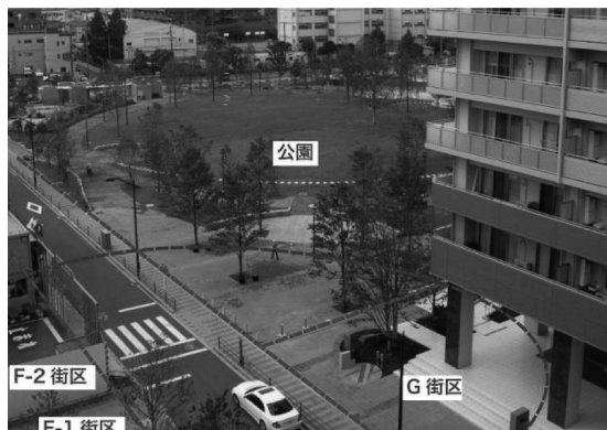
写真19 カルテット広場部分の状況
